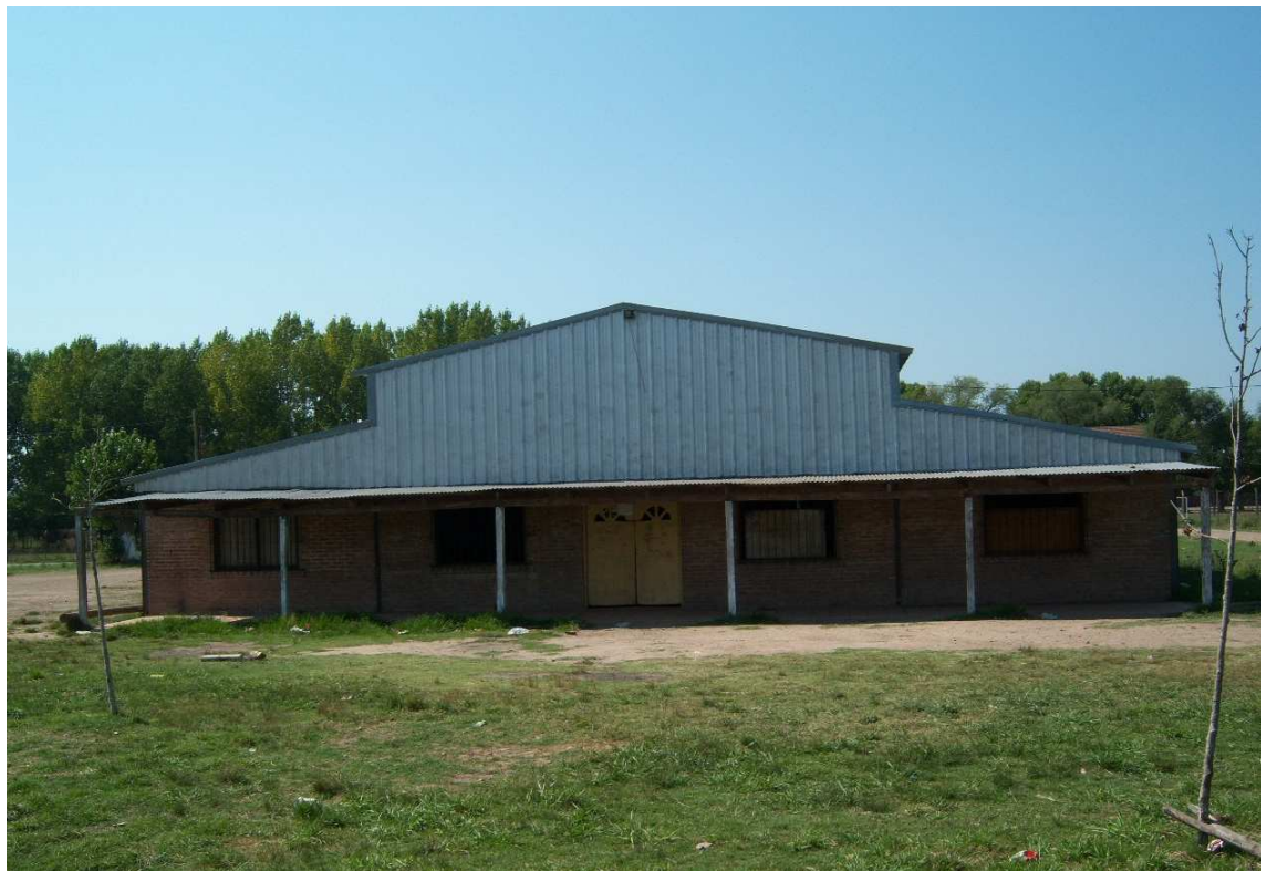
Frente de la Biblioteca Qomllalaqpi
